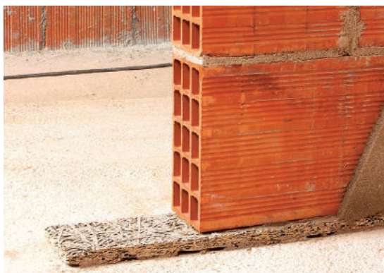
2.att. Starpsienas konstrukcijas principiālā shēma izmantojot fibrolītu
